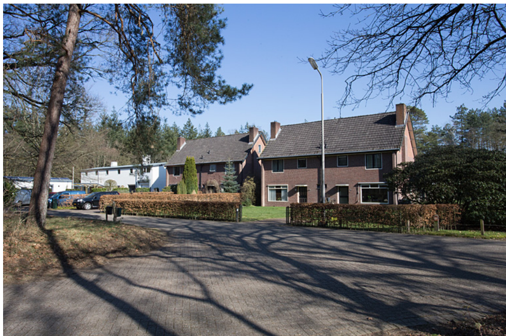
De vier dienstwoningen anno 2023. Het witte gebouw op de achtergrond is de voormalige marechausseekazerne.
